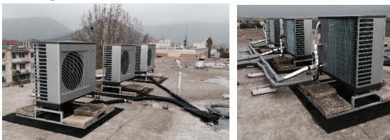
Kaskádovité propojení tří tepelných čerpadel systému vzduch-voda NIBE F2300 (střecha panelového domu v Turně nad Bodvou)
