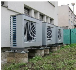
Kaskádovité propojení tří tepelných čerpadel systému vzduch-voda NIBE F2300 (střecha panelového domu v Turně nad Bodvou)
