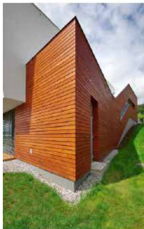
Sestup z horního podlaží do spodní společenské zóny umožňuje přímé schodiškové rameno s dřevěným obkladem, které kopíruje svahový terén a dostává se po něm „plazí“
