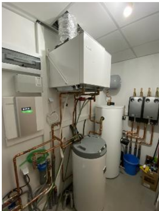
Ventilační tepelné čerpadlo NIBE F130
