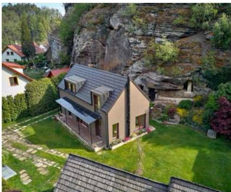
Foto z nadhledu vystihuje kompozici celého trojdomí se skálou, travnatým dvorem, předpolím a živým plotem na hranici pozemku. Zápraží je podezděno přírodním kamenem, na němž jsou položena dřevěná terasová prkna. Je kryto šedým bezkomůrkovým polykarbonátem na nosné konstrukci ze subtilních ocelových profilů. Architektura domu včetně barevnosti, materiálů a moderních vikýřů koresponduje se stávající budovou vzadu
