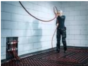
Instalace podlahového topení
